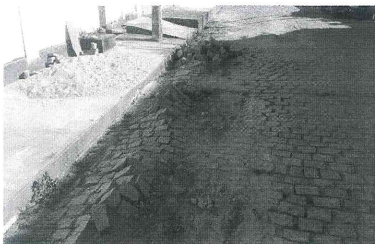
Foto 03 – Rua José Leite Teixeira – Bairro Parque dos Jaraguá
